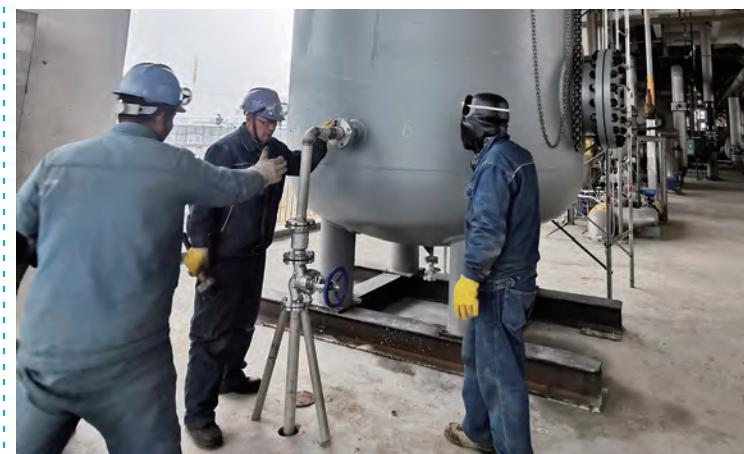
12月6日,利海化工公司双氧水装置安装SIS联锁储气罐,配备专用的仪表储气罐,保障双氧水装置的安全生产。图为员工在安装仪表储气罐和配管作业。(林涛)
